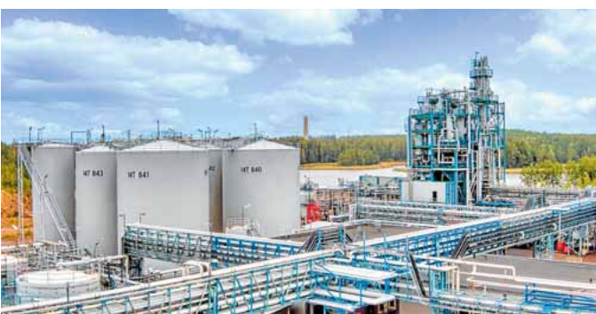
Segunda vida La planta Tecoil de TotalEnergies en Finlandia regenera 50.000 toneladas anuales de aceite usado que convierte en bases de alta calidad
